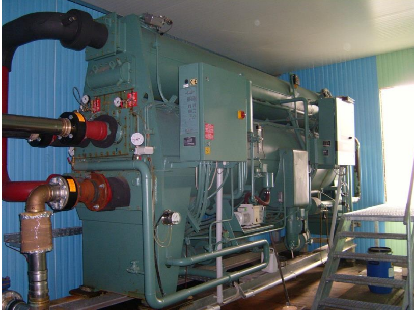
6 nolu Resim: Kullanılan absorpsiyonlu soğutma makinesine bakış [12]
