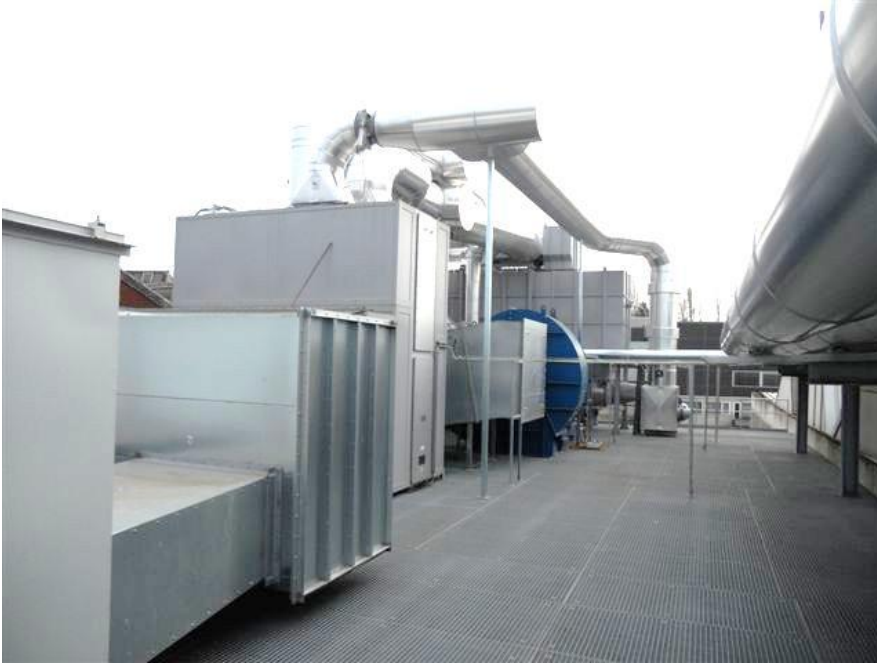
6 nolu Resim: Dortmund'daki Bucyrus şirketindeki büyük [parça] lak boyama tesislerinin çıkışındaki Duplex tesisi
